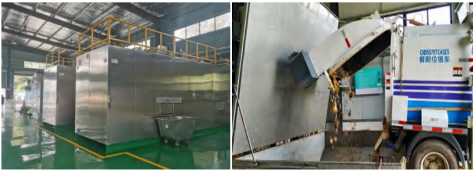
图 7.8 餐厨垃圾处置中心
