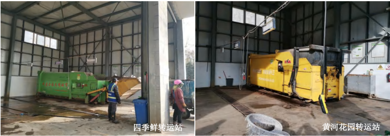
图 3.4 现状垃圾转运站
