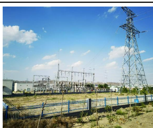
原光伏场区升压站
