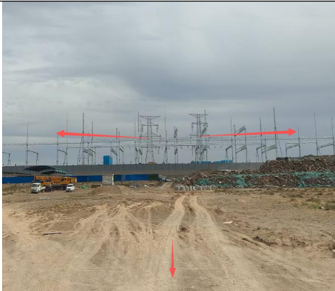
江南 330 千伏变电站出线（架空+电缆）
