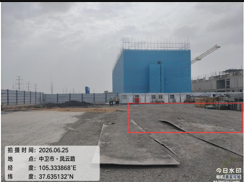
变电站站址区域
