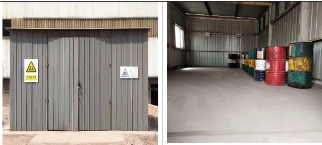
图 4-2 本项目依托的危险废物暂存间情况
